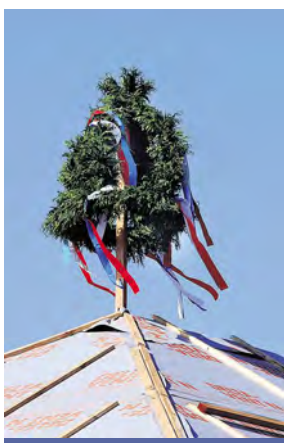
Der Richtkranz krönt den Rohbau
