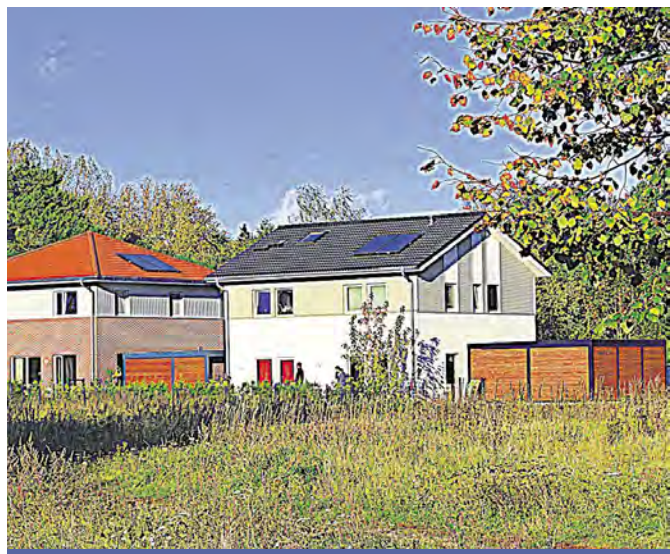
Bislang galten keinerlei rechtliche Anforderungen an den Inhalt einer Baubeschreibung. Das ist jetzt anders FOTO: T. WOLF
